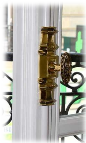
Récupération des anciennes crémones
